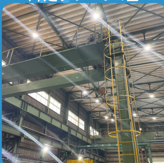
片足クレーン4基
