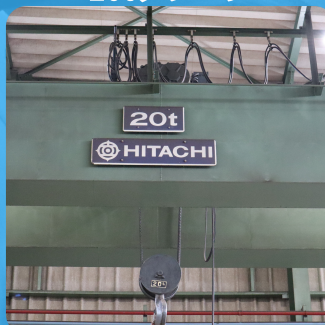
20tクレーン
